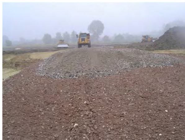
Aanbreng van geotextiel op een werfweg met daarbovenop een laag COPRO-gekeurd breekpuin
