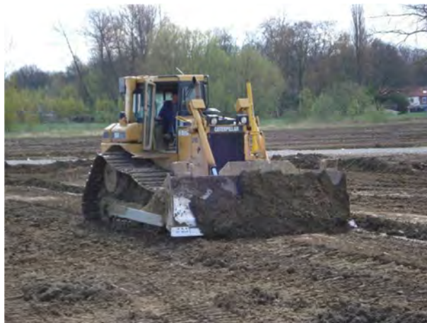
Openspreiden en egaliseren van de bouwvoor met kranen en bulldozers op rupsbanden
