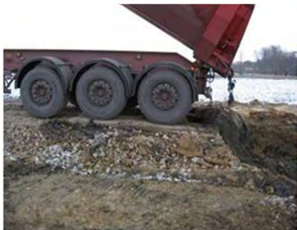
Aanvoer van grond op vaste afkippunten en openspreiden met kranen op rupsbanden
