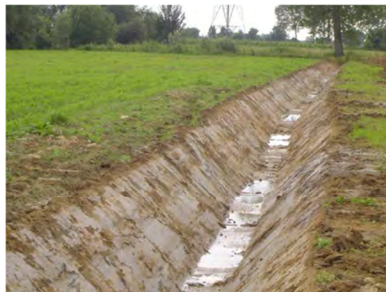
Graven van afwateringsloten
