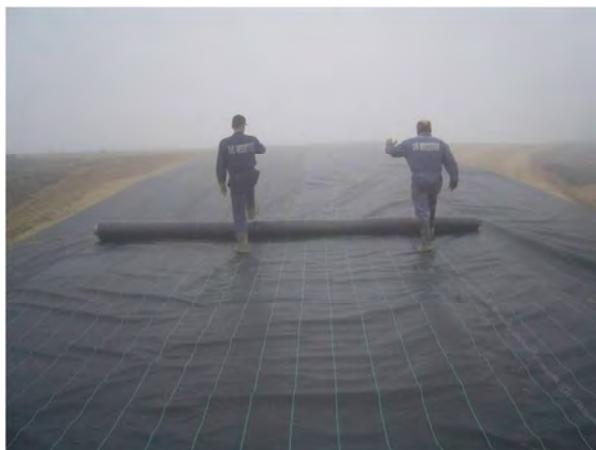
Aanbreng van geotextiel op een werfweg met daarbovenop een laag COPRO-gekeurd breekpuin
