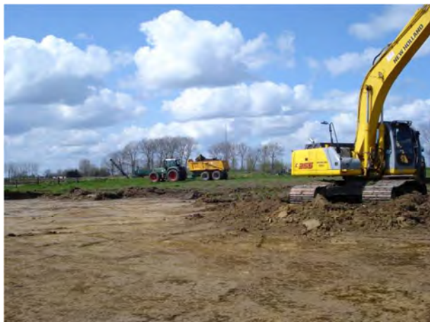
Openspreiden en egaliseren van de bouwvoor met kranen en bulldozers op rupsbanden
