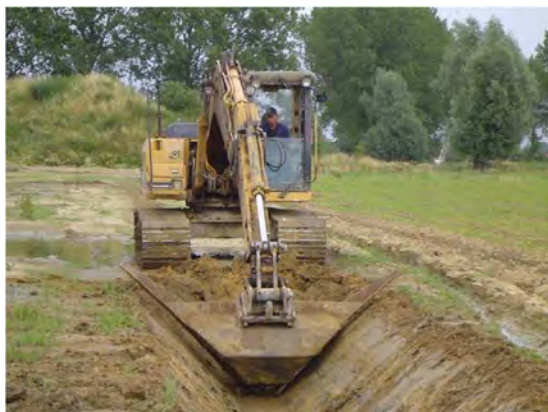
Graven van afwateringsloten
