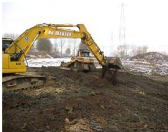
Aanvoer van grond op vaste afkippunten en openspreiden met kranen op rupsbanden
