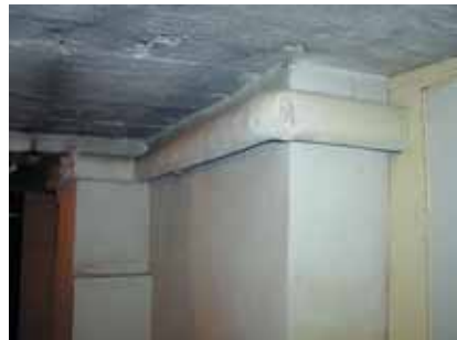
Voorbeeld ongebonden toepassing: plaasterisolatie
