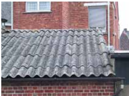
Voorbeeld hechtgebonden toepassing: golfsplaten
