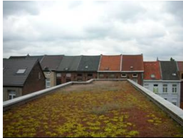
extensief groendak boven de zijvleugel
