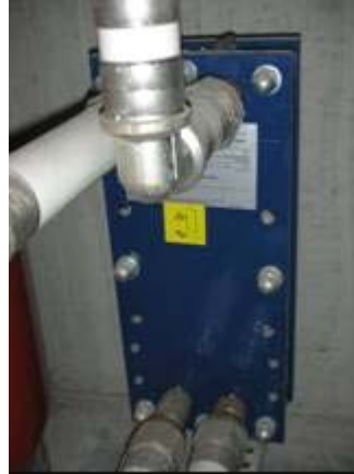
warmtewisselaar (platen)
