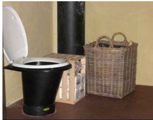
waterloos toilet met op de achtergrond de afvoerleiding van het hoger gelegen toilet. (foto: www.ddmagazine.com )
