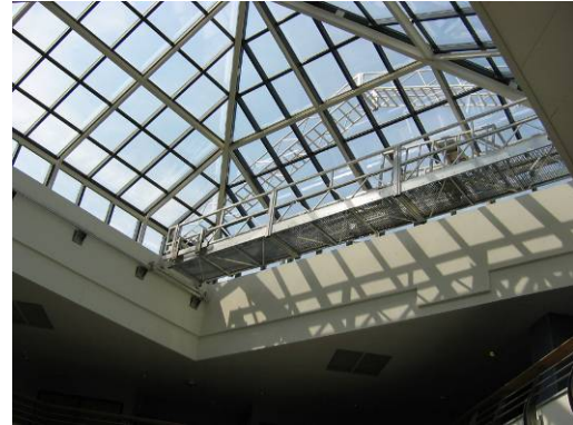
Figuur 6: RSZ-gebouw Atrium - beglazing
