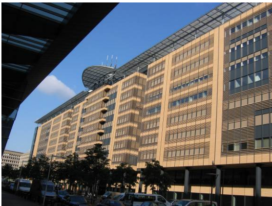
Figuur 1: RSZ-gebouw - Buitenzicht
