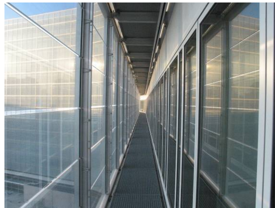
Figuur 2: Berlaymont gebouw Spouw tussen de 2 huden
