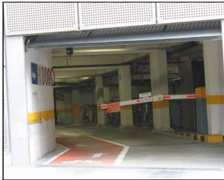
Ingang tot parking van de Europese Commissie: verkorte hefboom en speciale markering voor fietsers
