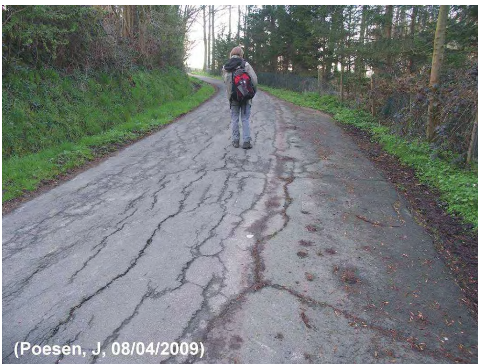
Foto 3 : Schade aan het wegdek ter hoogte van GV. PJ_28b.
